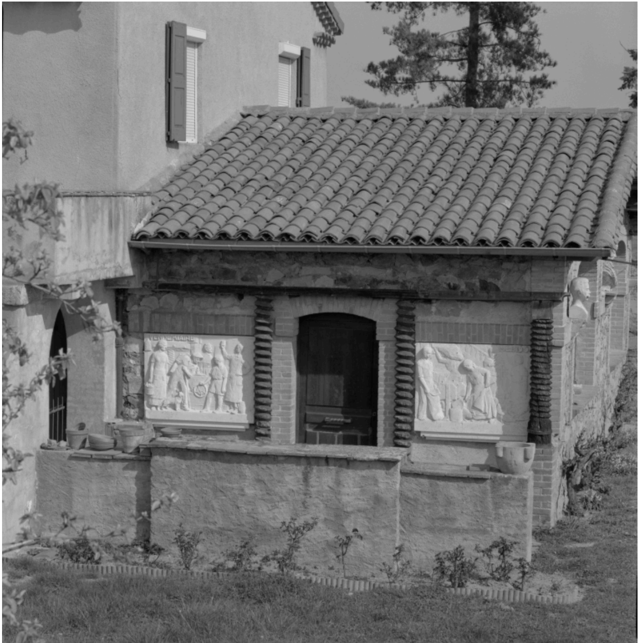
Vue d'ensemble de l'élévation principale de l'atelier.
