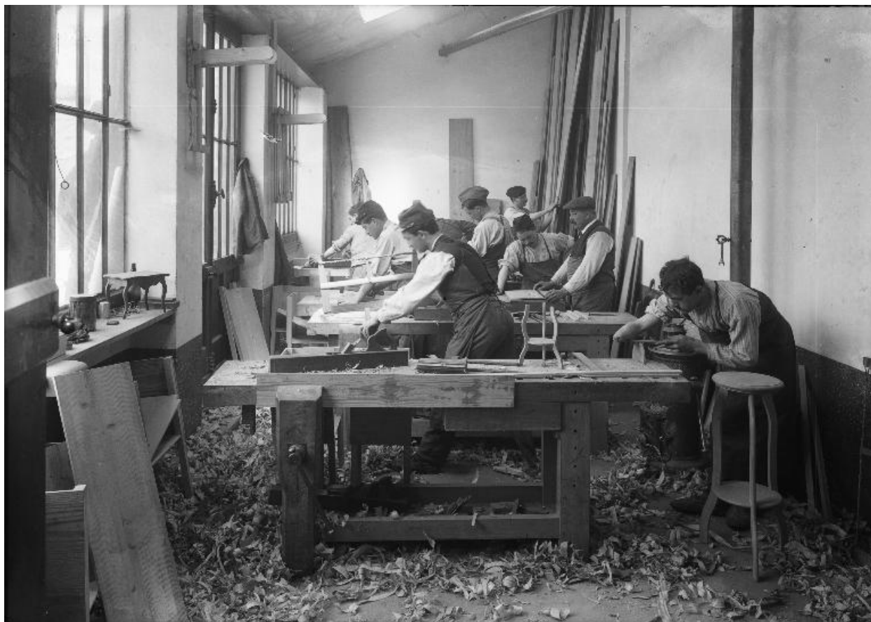
Vue de l'atelier de fabrication des jouets (situé au nord, ajout détruit en 2013), vers 1915 (Bibl. mun. Lyon, fonds Jules Sylvestre, plaque de verre, P0546_S 1284).
