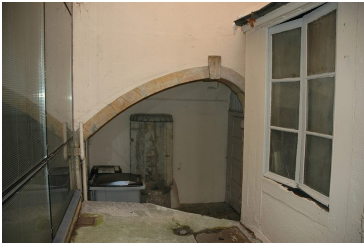
Couvent : 12 place Antonin-Gourju, vue générale du puits depuis la cour
