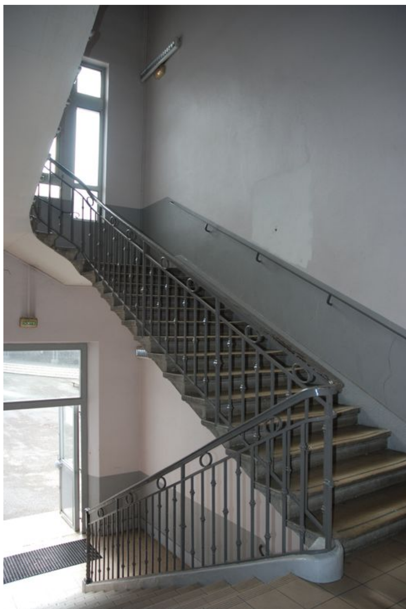
Bâtiment C : escalier, deuxième volée
