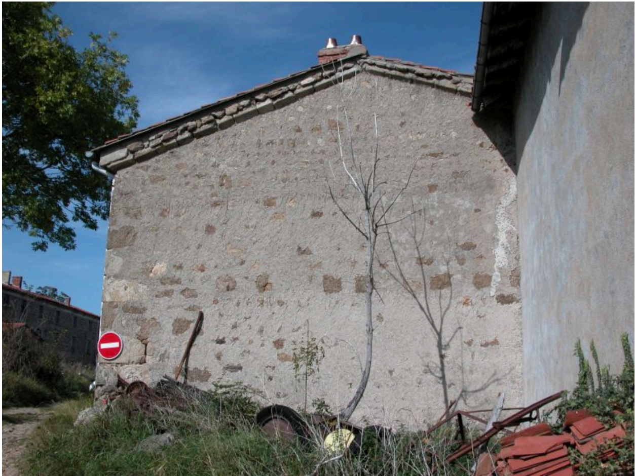
Vue du mur pignon sud du logis 1, surmonté d'une corniche en granite (à droite, mur arrière du logis 3).
