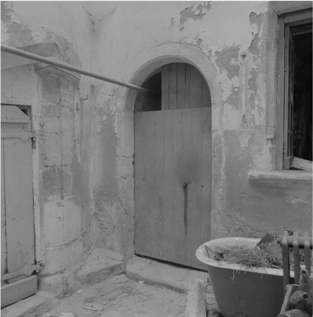
Maison partagée, 16 rue du Port, cour intérieure, détail : porte en plein cintre.
