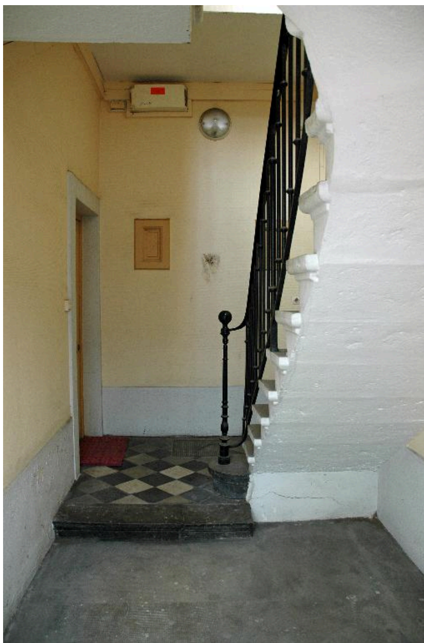
Vue intérieure du bâtiment sur cour : l'escalier
