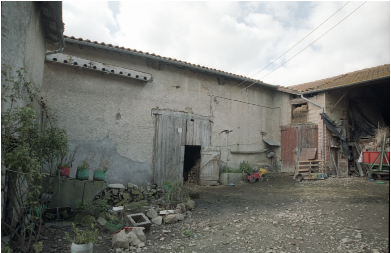
Vue de la grange-étable, depuis le nord-est.
