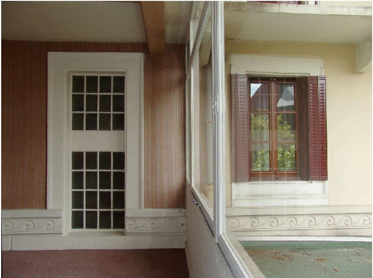
Liaison des deux ailes au premier étage
