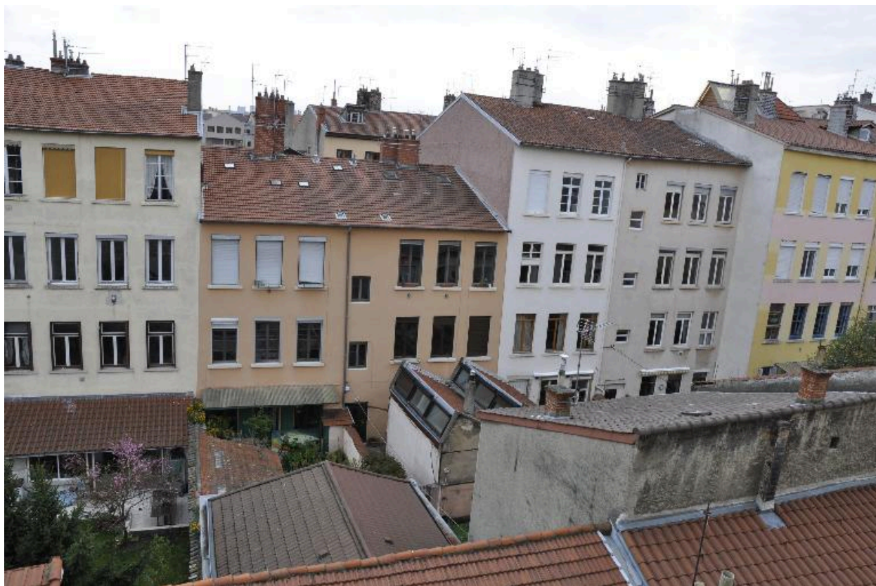
Vue ouest de l'immeuble de deux étages
