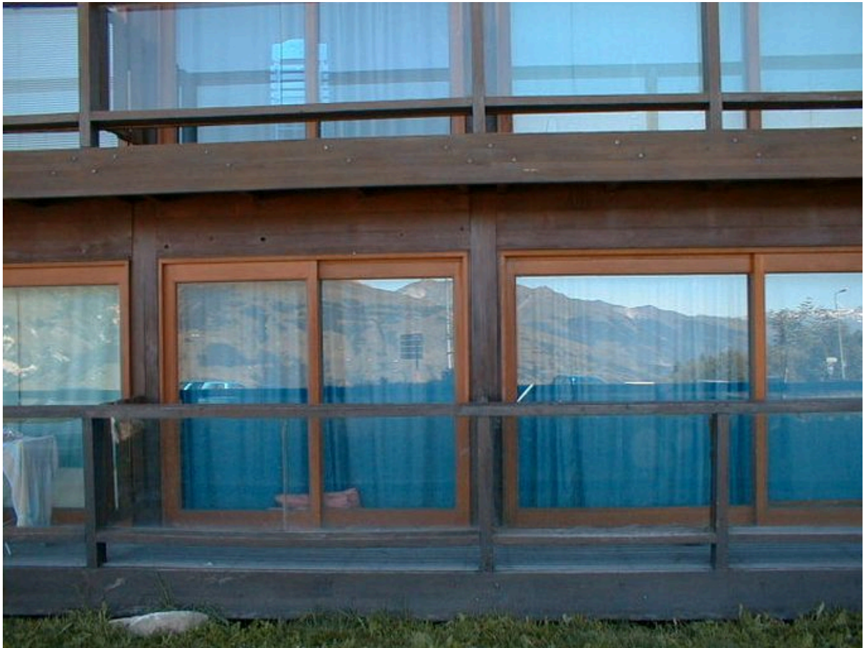
Arc 1600. Immeuble Pierre Blanche. Immeuble parallèle à la pente avec galerie latérale et coursive horizontale. Détail de la façade ouest
