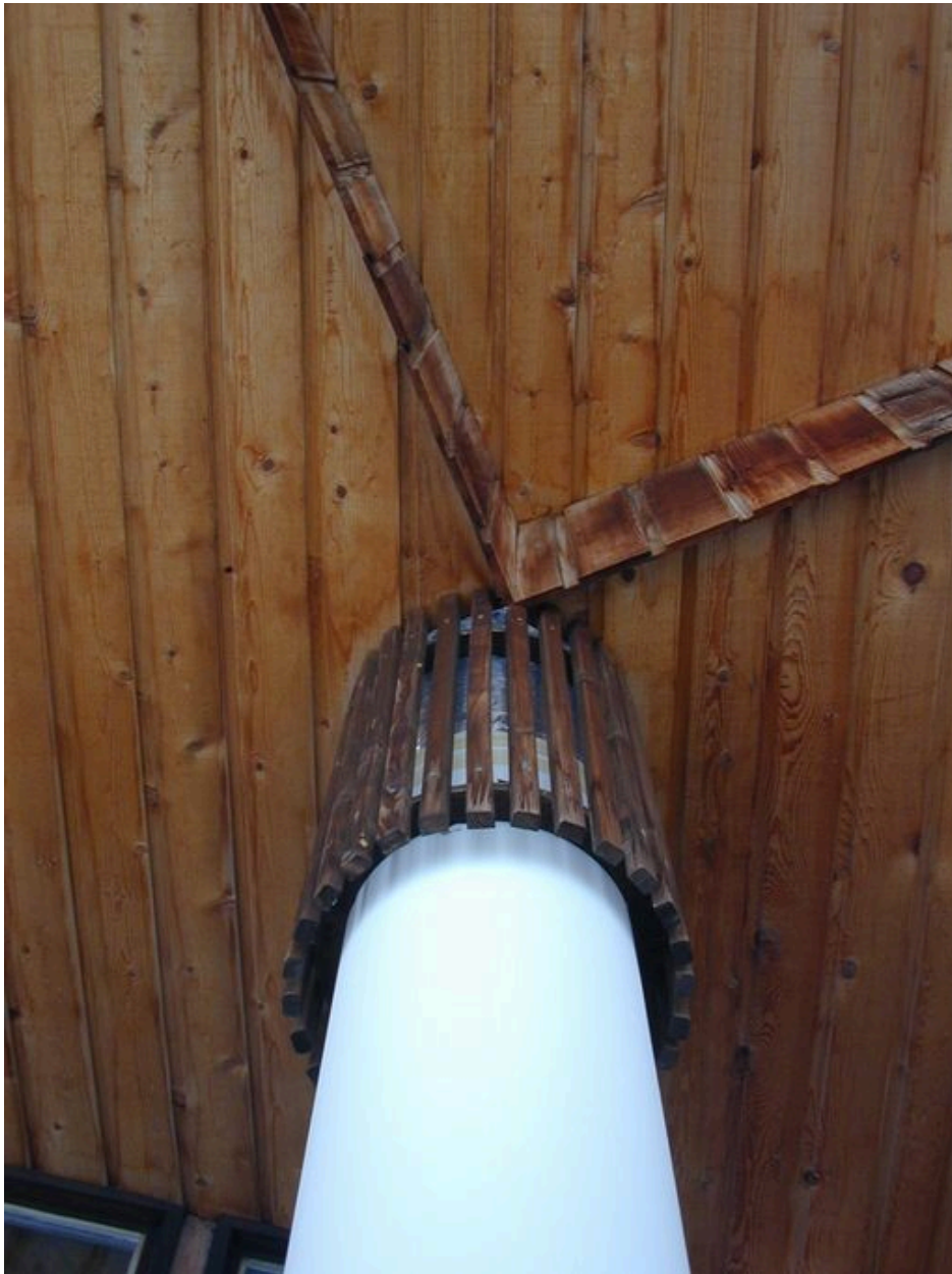
Détail d'une colonne supportant l'auvent de l'entrée aval
