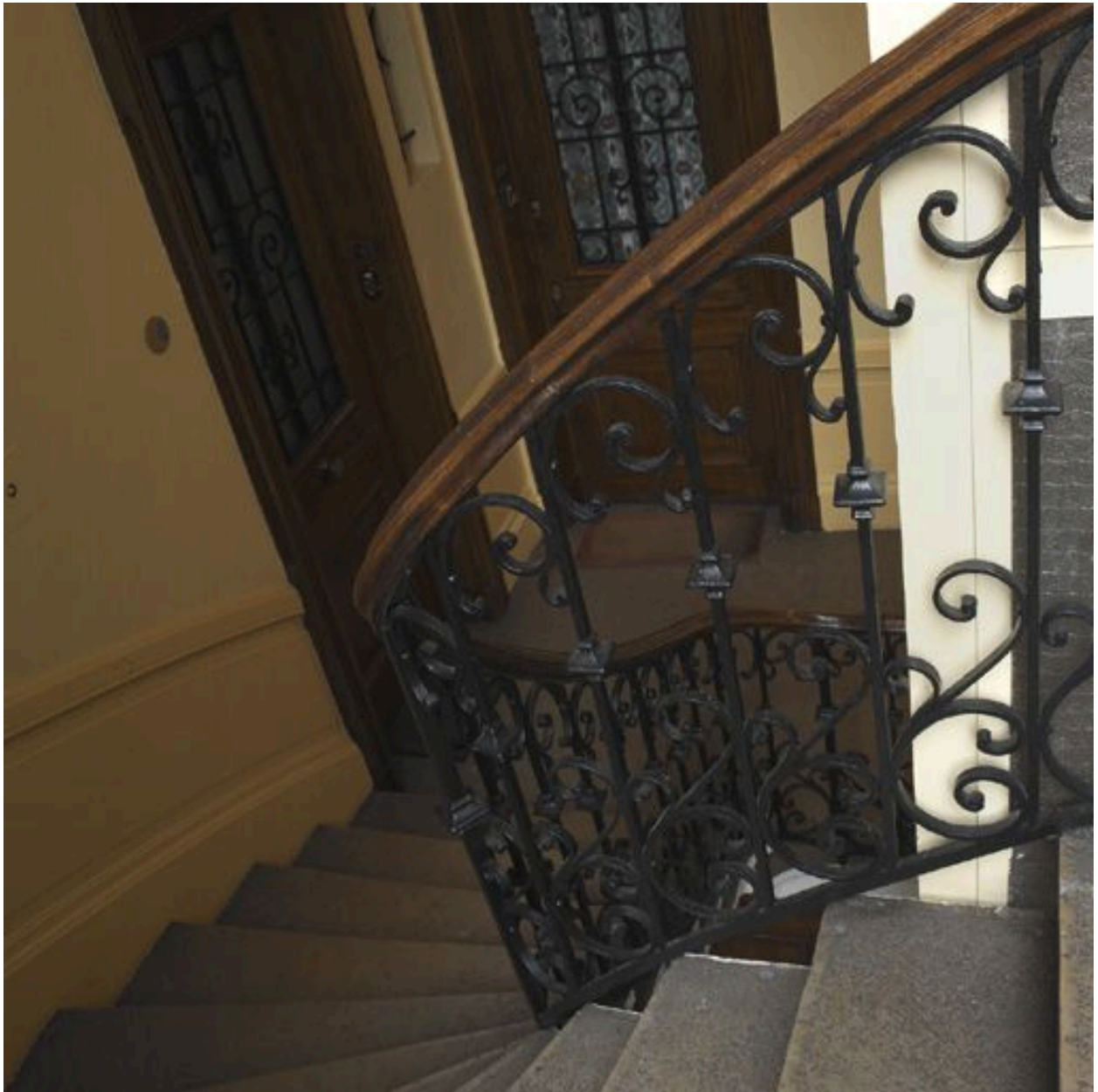
Détail de l'escalier
