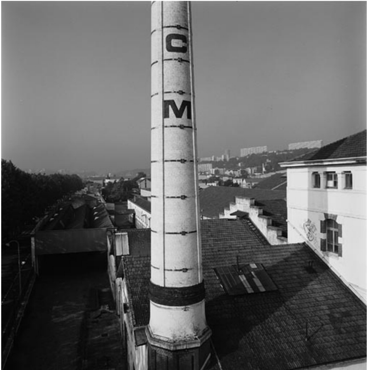
Vue d'ensemble nord, à gauche imprimerie
