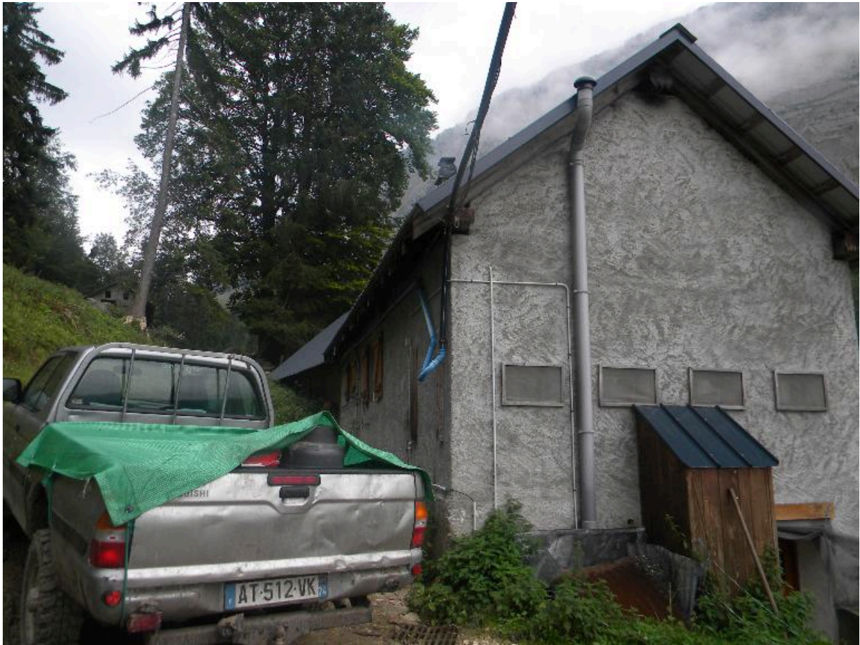
Vue du pignon nord et de la façade arrière du bâtiment d'alpage des Granges Neuves (2008 B7 913).
