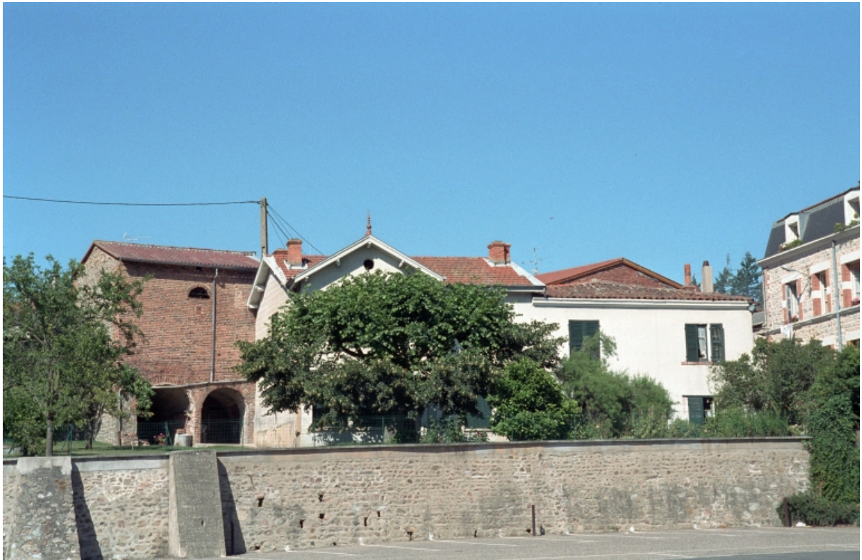
Boën, îlot 15, Saint-Vincent (place) 8 / Lignon (rue du) 3, 5, 7. Vue générale des maisons
