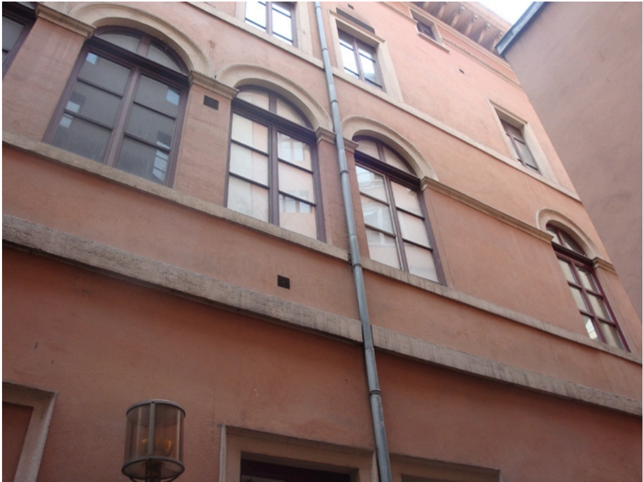
Angle est du deuxième niveau de la façade sud
