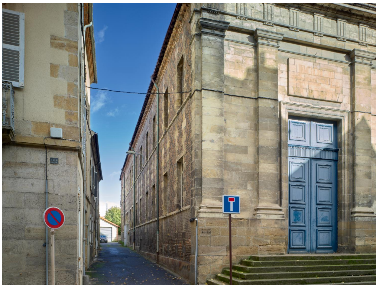
Aile nord, élévation nord et ruelle conduisant à l'ancienne basse cour
