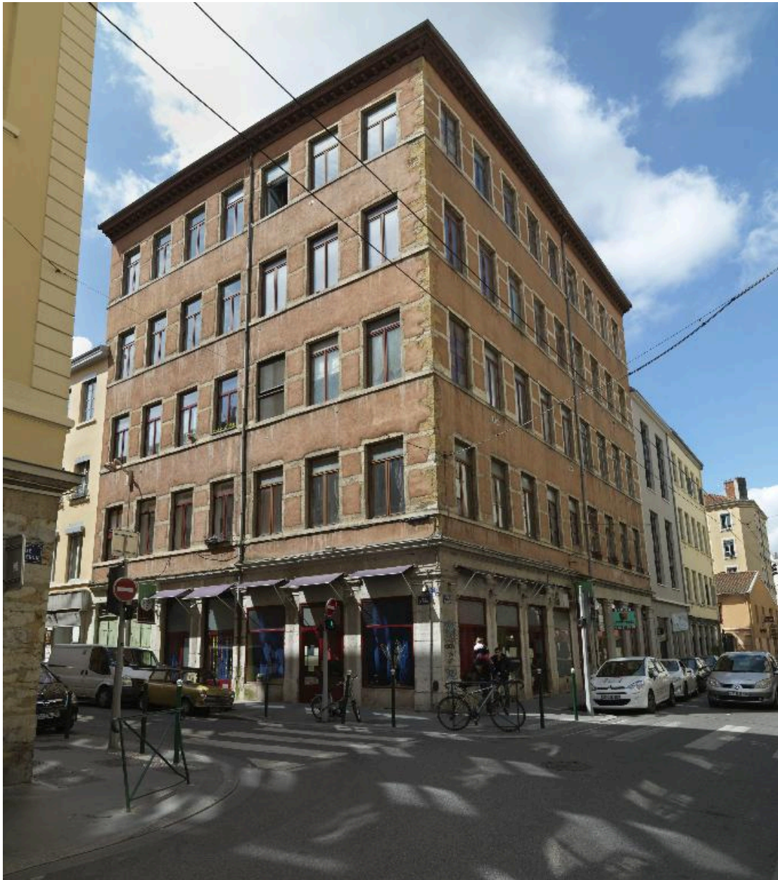
Vue d'ensemble nord est
