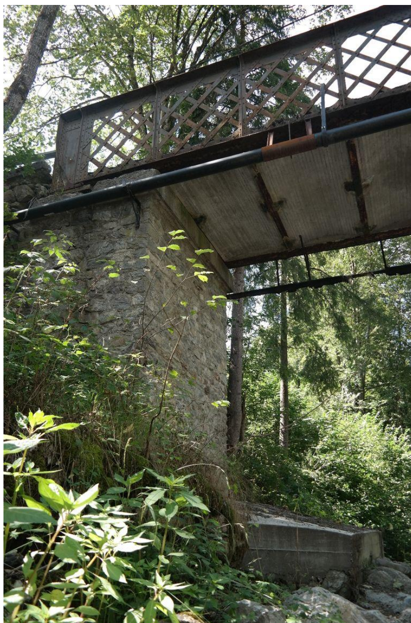
Passerelle de Sous-le-Pas culée rive gauche
