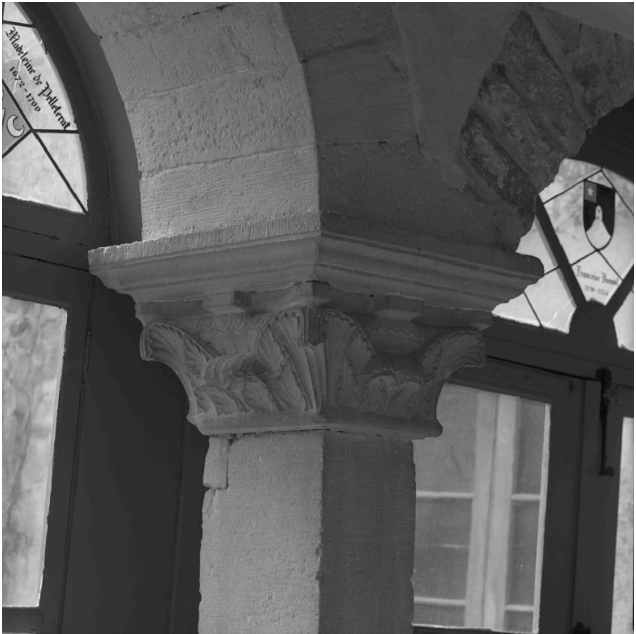
Chapiteau du pilier 3.
