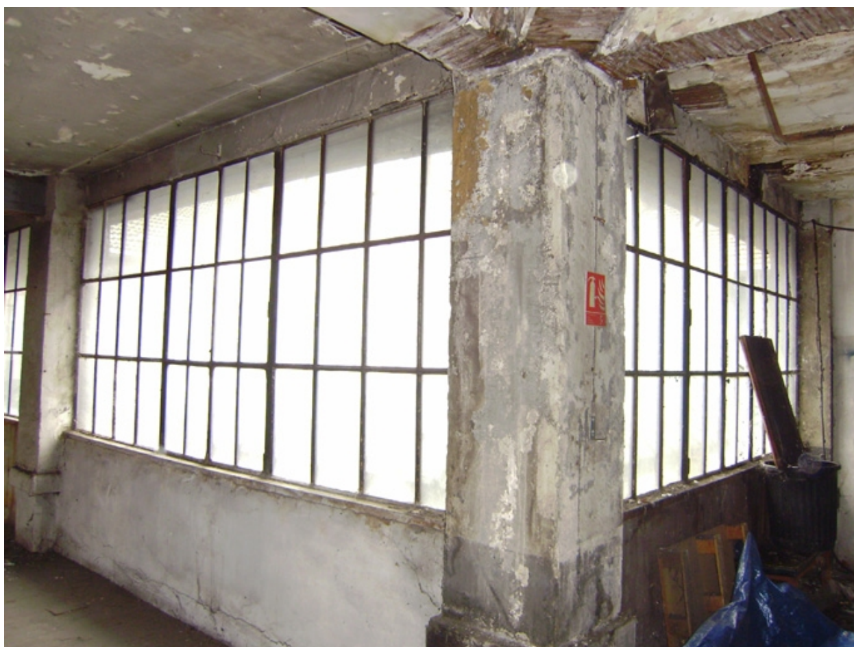
Structure béton et baies rectangulaires
