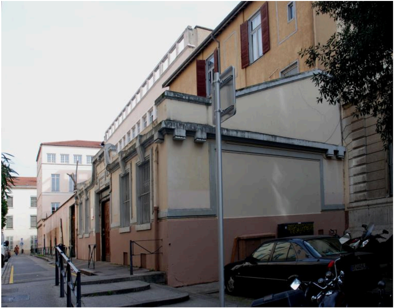
Vue d'ensemble du 2e corps de bâtiment impasse Catelin, depuis le sud
