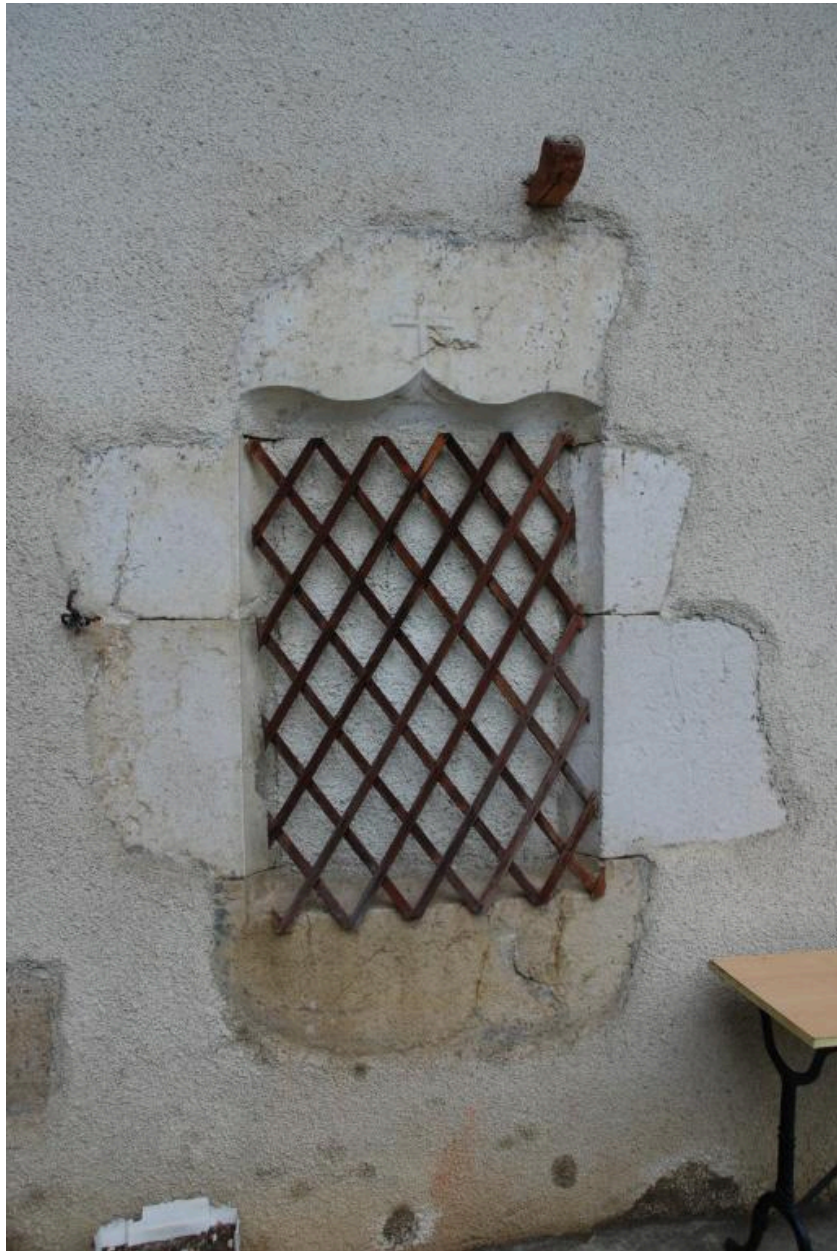
Détail d'une fenêtre (murée) de l'étable : encadrement à cavet et accolade.
