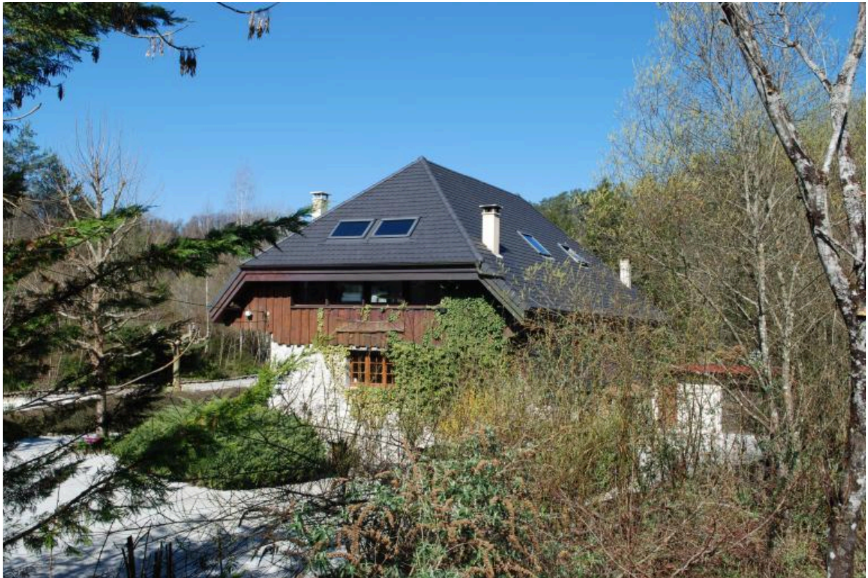
B6 363, Vers Chéran, ancien moulin. Vue rapprochée de l'actuelle maison, ancien moulin.
