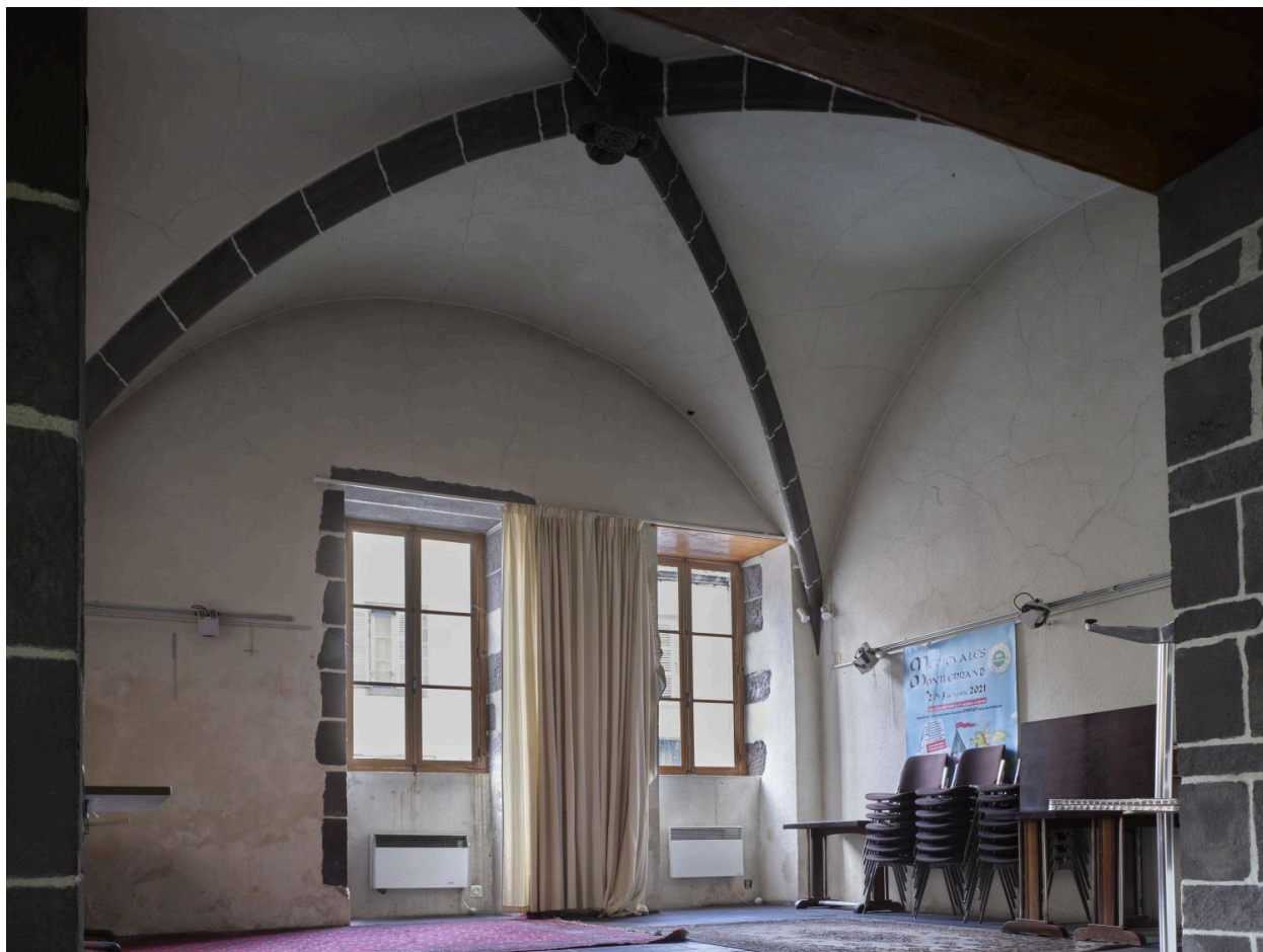
Rez-de-chaussée, salle à l'angle de la rue de la Rodade et de la place Poly, vers l'ouest
