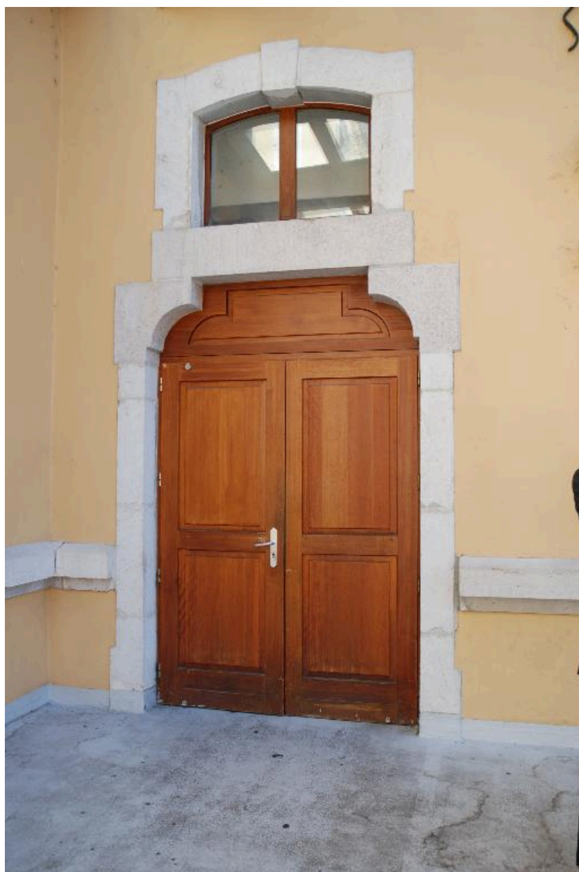
Cour 2 : détail d'une porte
