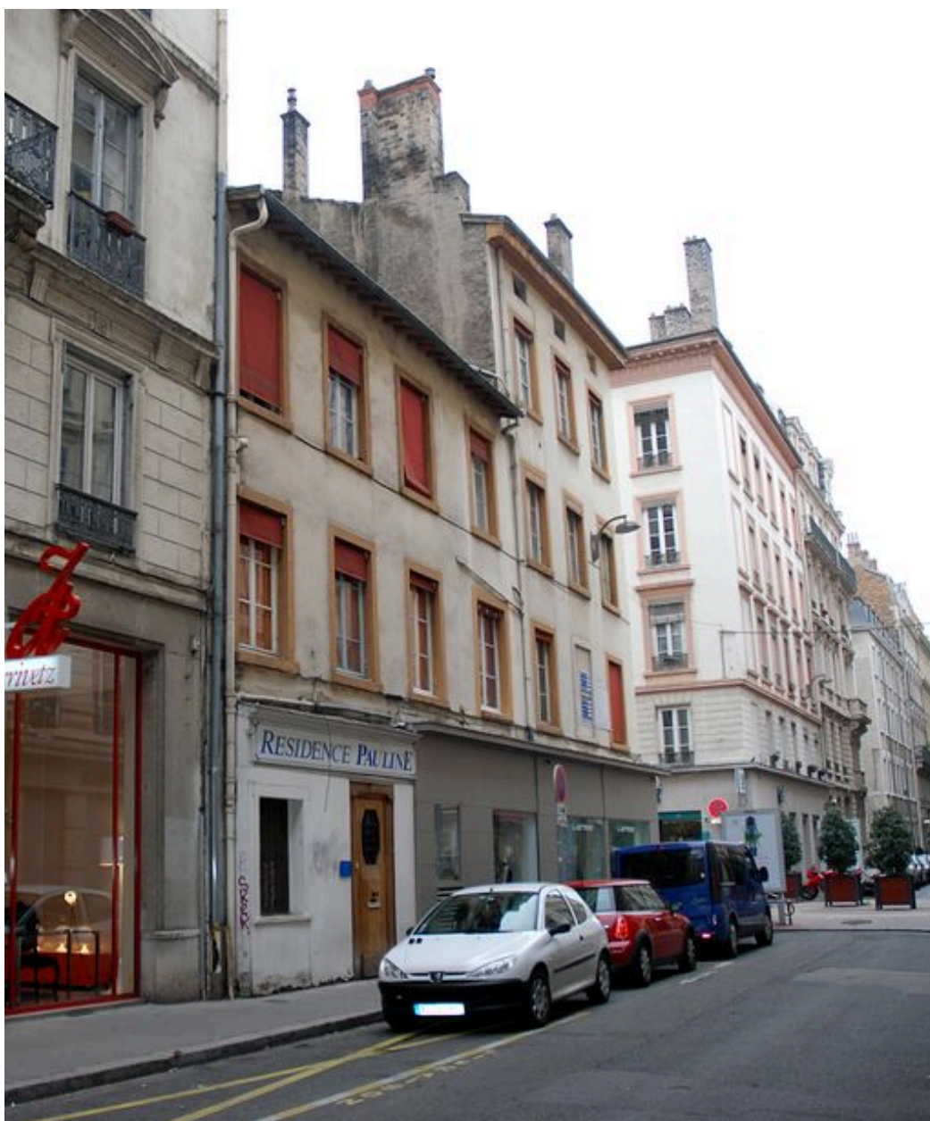
Elévation latérale nord, depuis l'est
