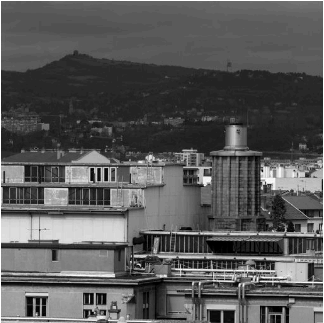
Vue du toit de la chaufferie ; à droite la station électrique
