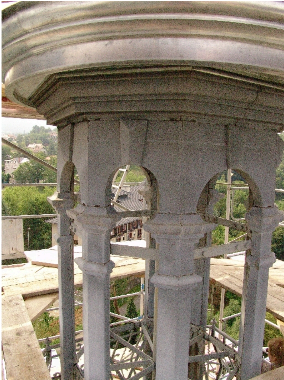
Détail du lanternon
