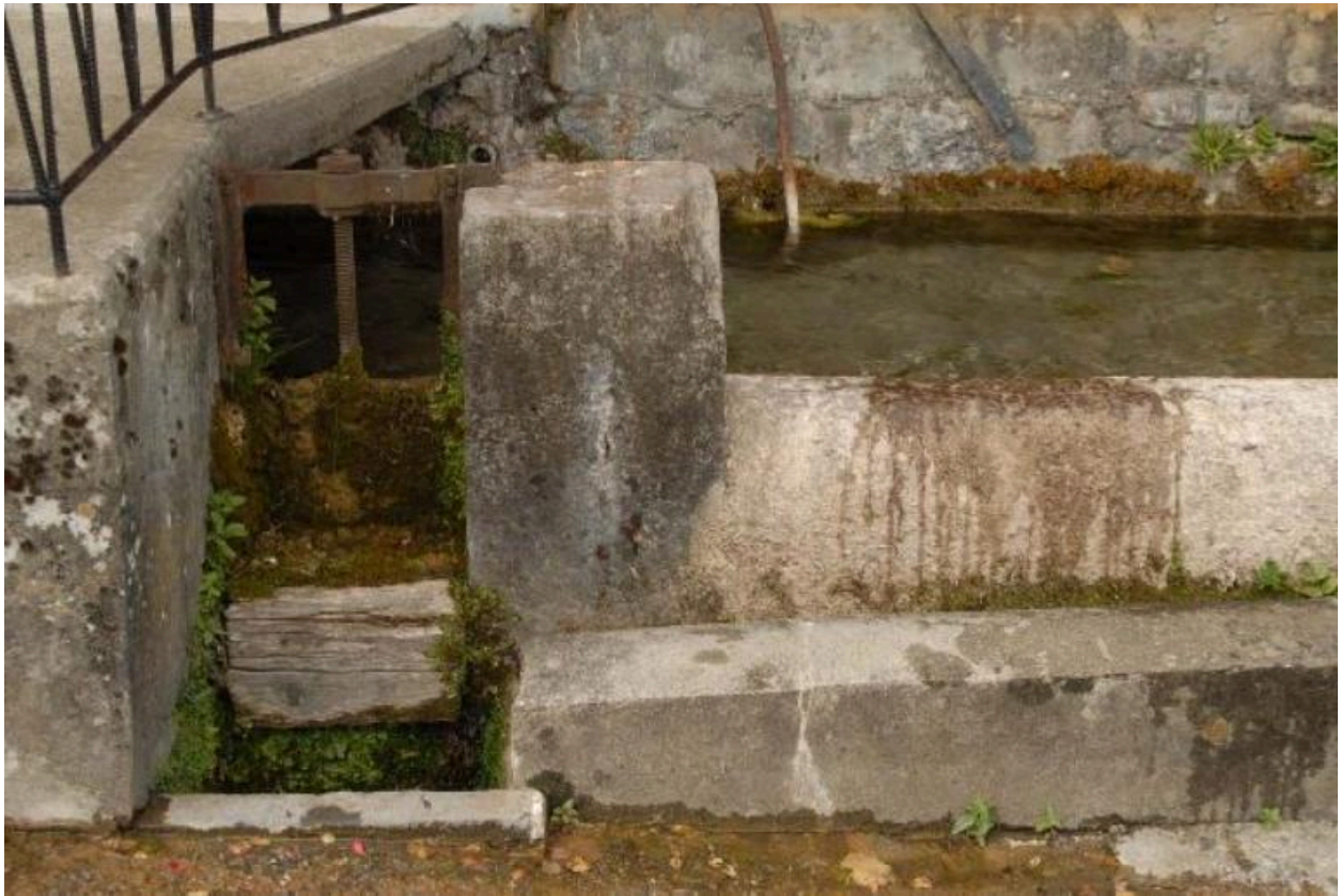
Vanne-déversoir en amont de la forge, 2009.
