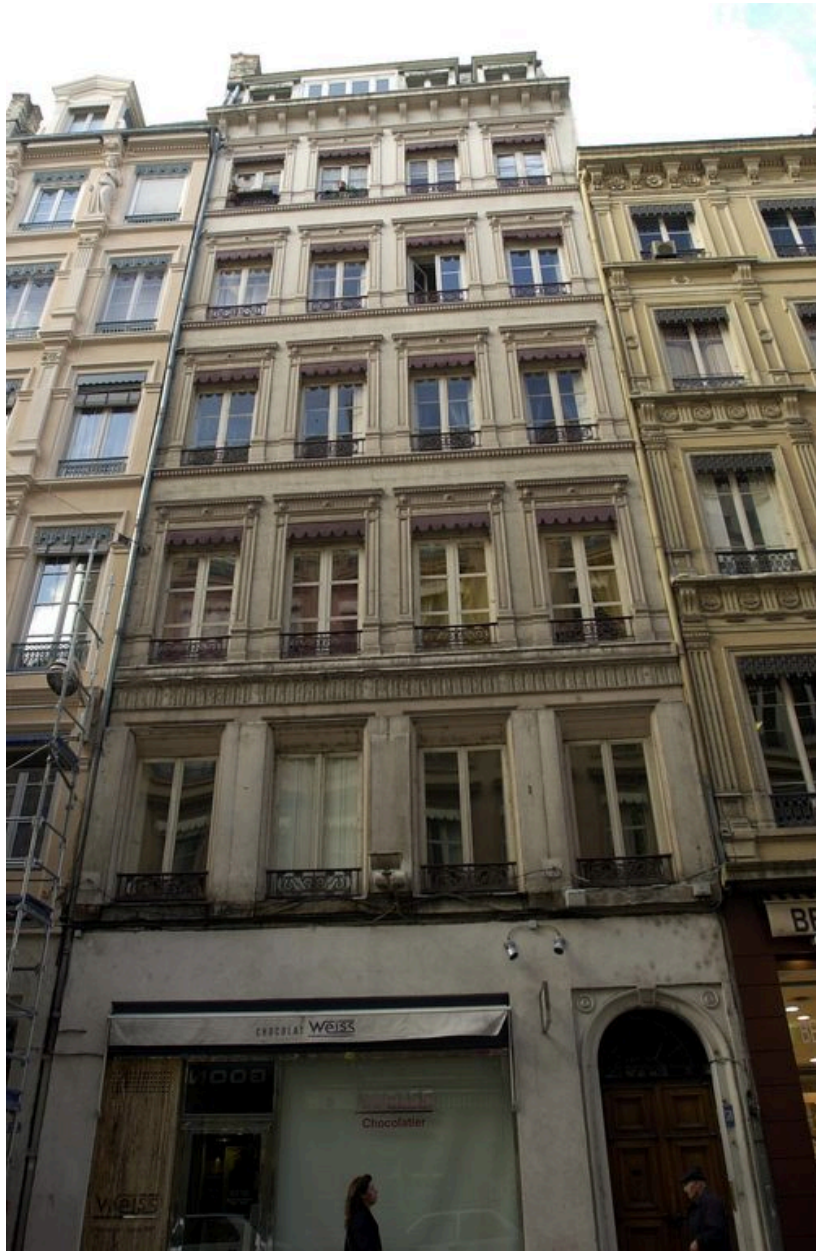
Vue générale rue de Brest
