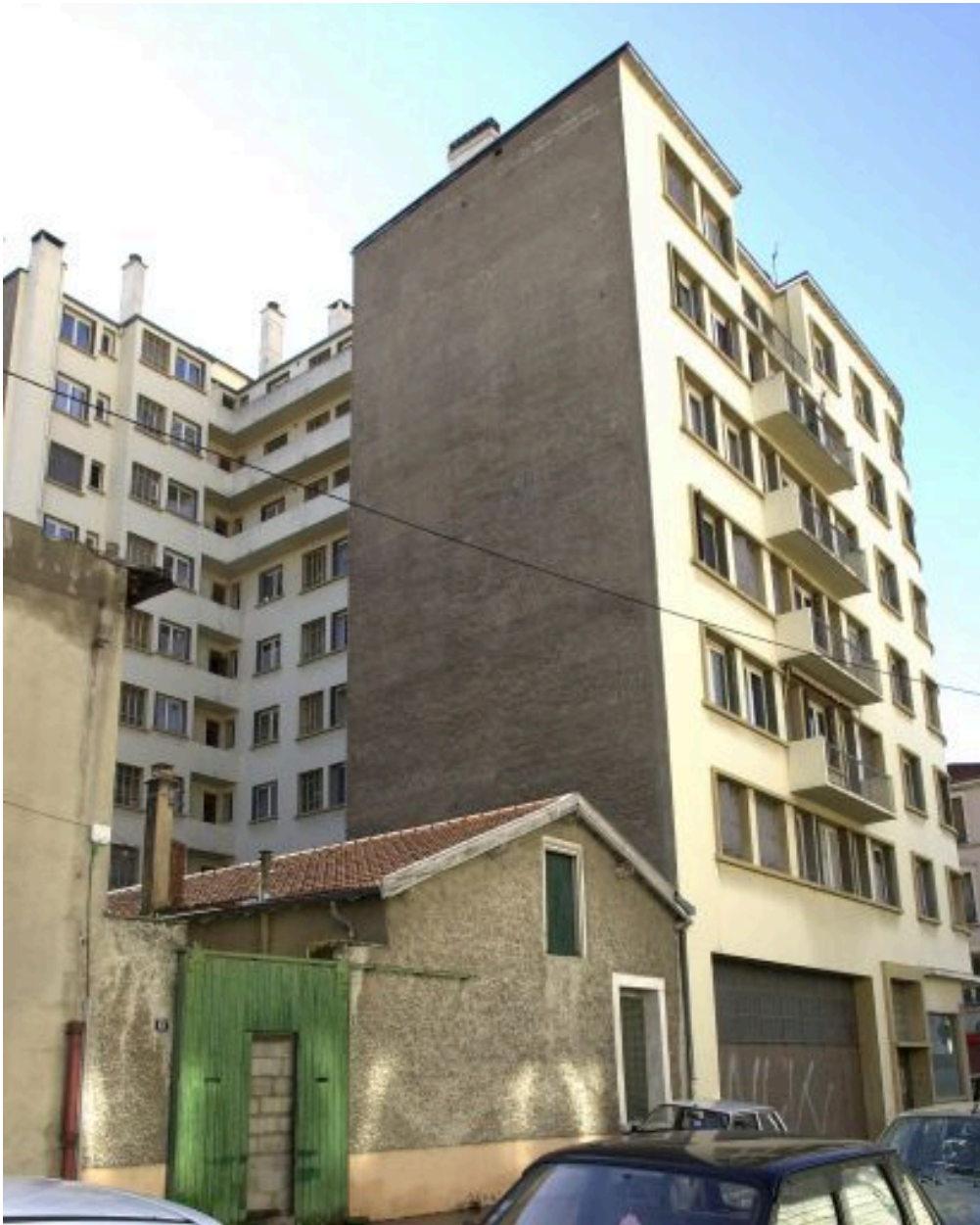
Elévation rue Seguin et immeuble mitoyen au sud
