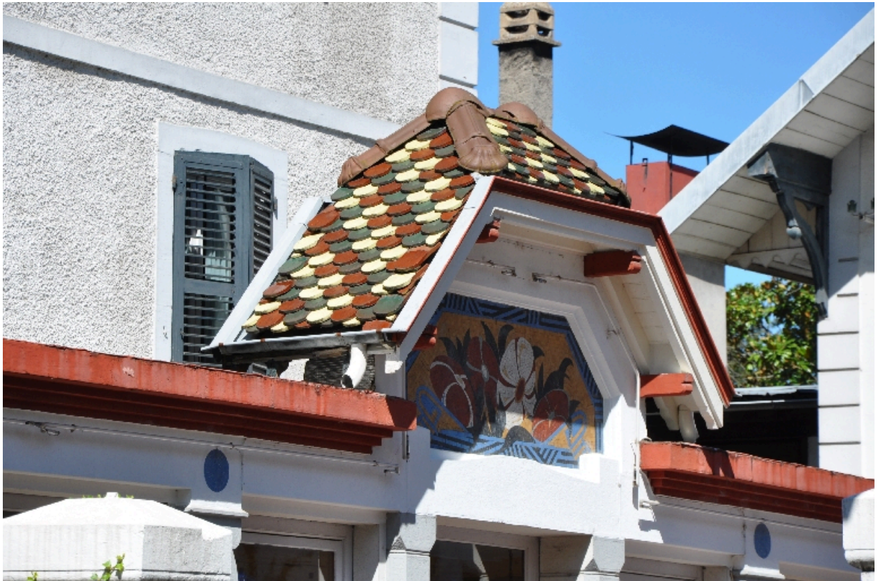
Couronnement de l'entrée sur cour
