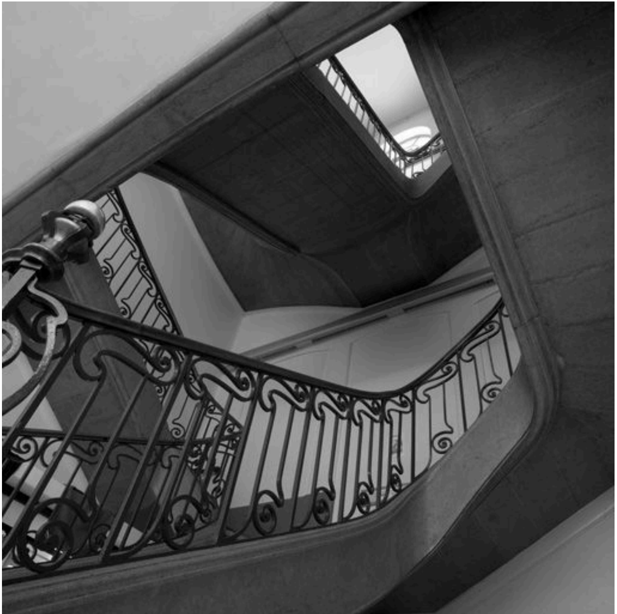
Bâtiment B, partie centrale, grand escalier, vue par dessous
