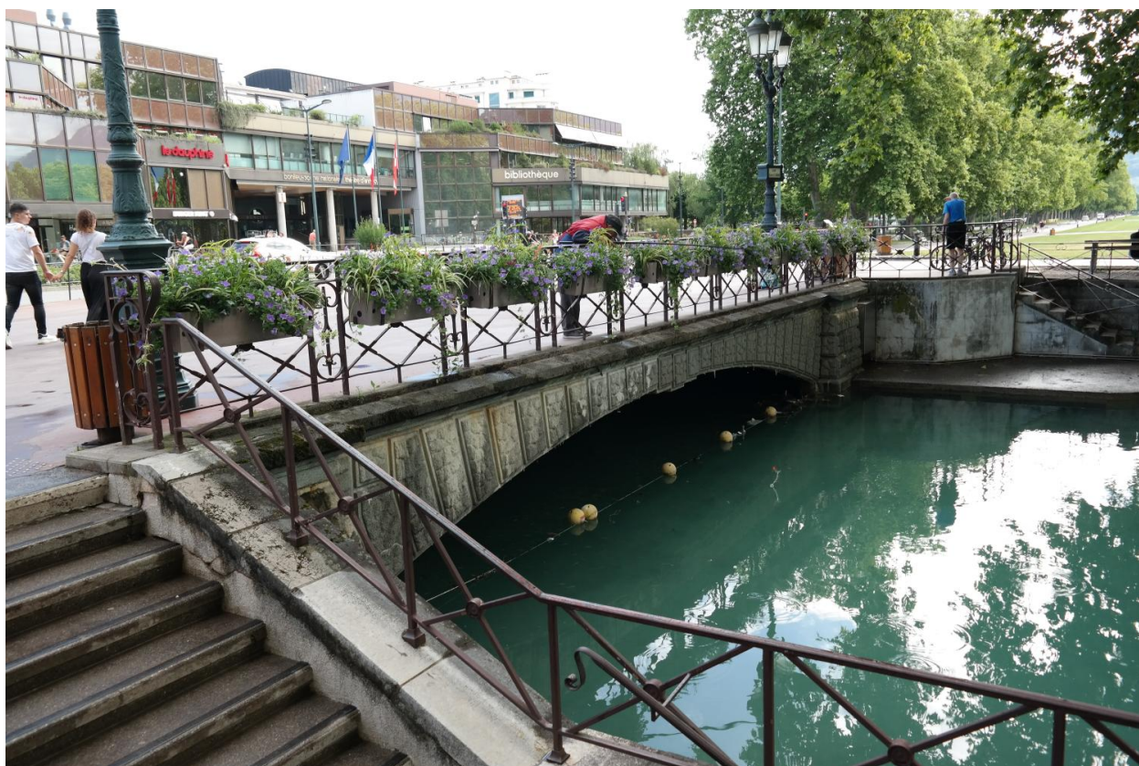
Pont Albert Lebrun, vue de la face amont
