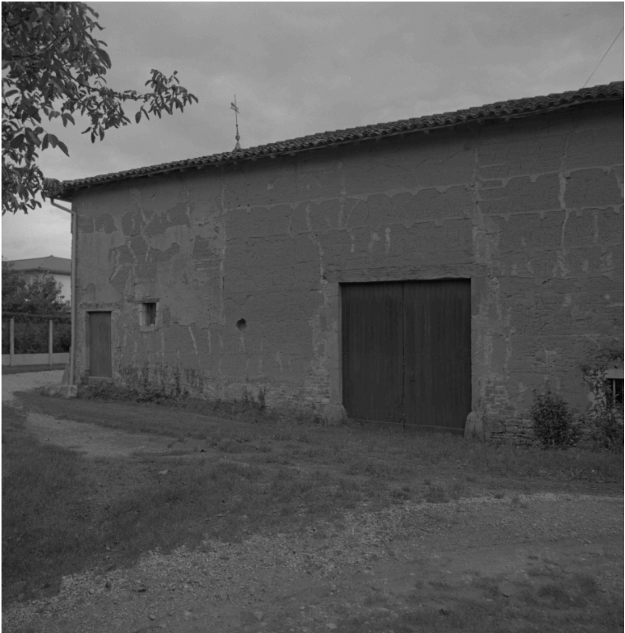
Élévation postérieure partielle côté nord : porche et dépendance.
