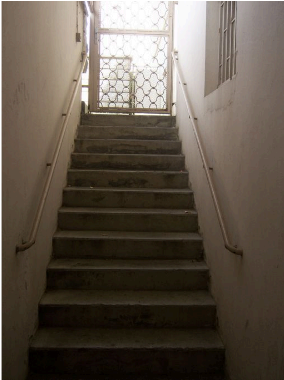
Escalier latéral Sud menant au sous sol
