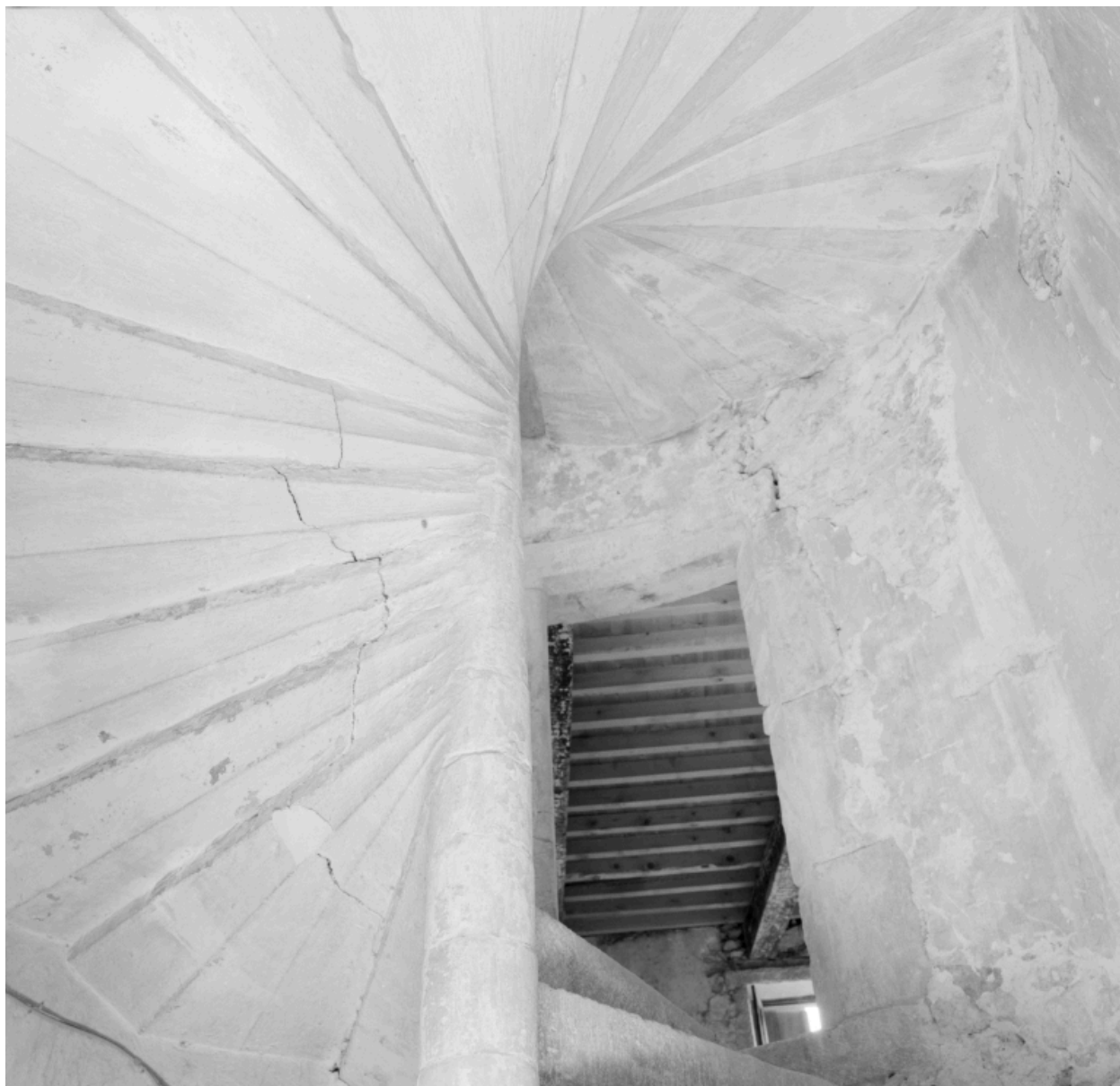
Couvrement de l'escalier en vis.
