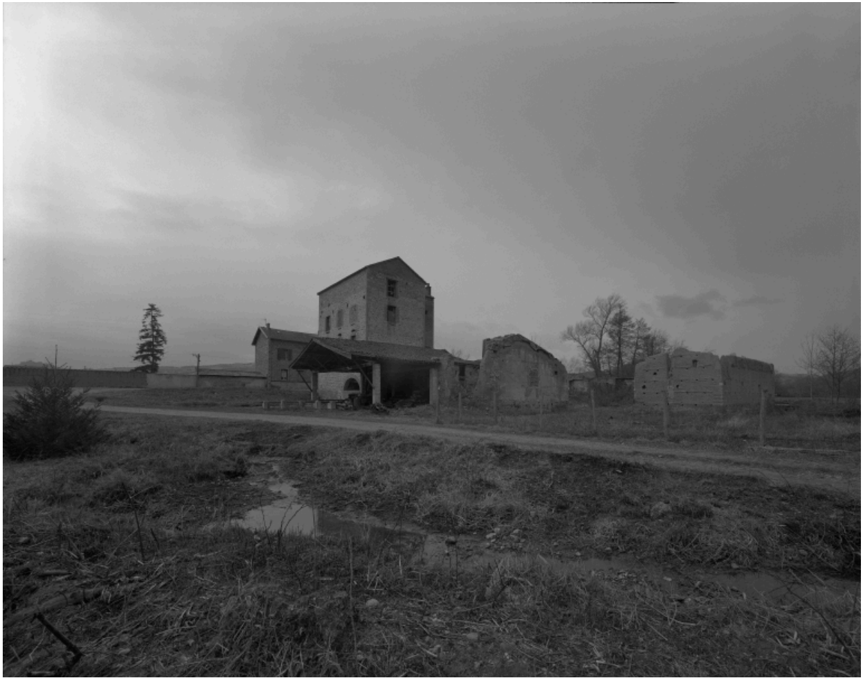
Vue générale depuis le nord, du site avec le moulin et la scierie au premier plan.
