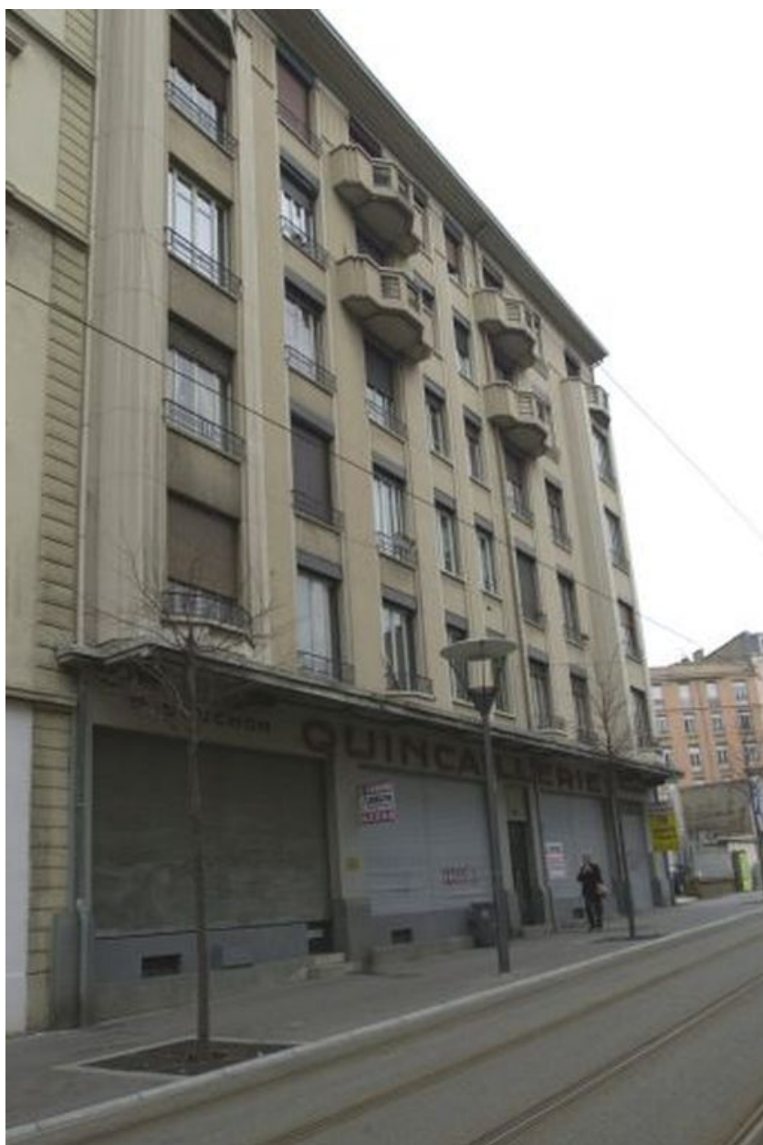
Vue de l'élévation depuis le nord-ouest
