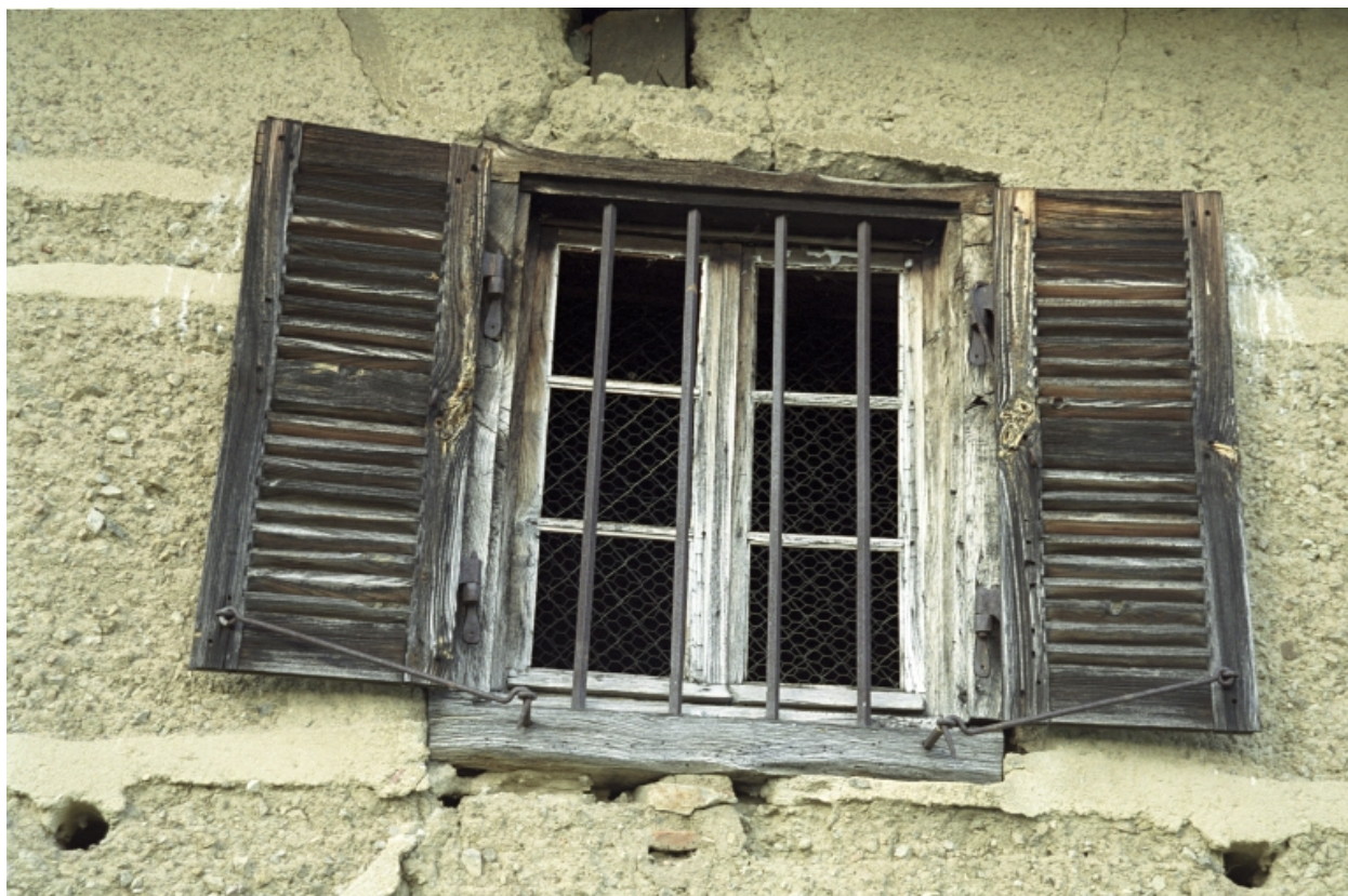
Saint-Sixte, Ciergues (1987 D3 961, 962), type B1. Détail d'une baie du logement de valet.
