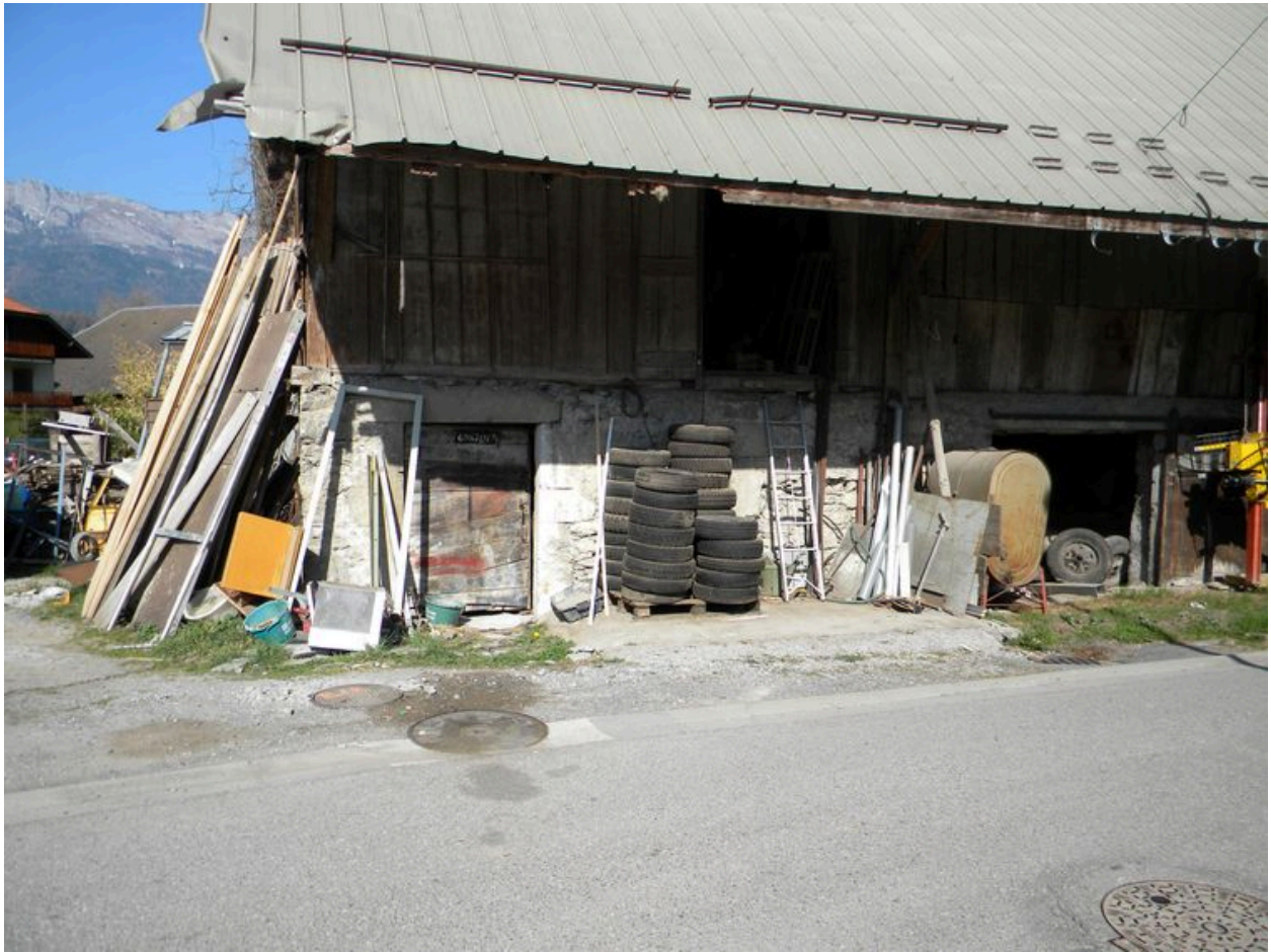
Vue de la façade au niveau de l'étable sud
