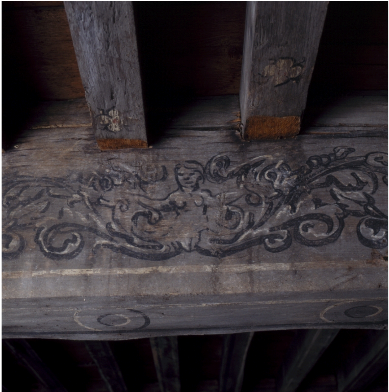
Corps de logis sud-ouest, premier étage, chambre dite de Jehan Papon, porte sud-ouest : détail intérieur des rinceaux peints sur les poutres.
