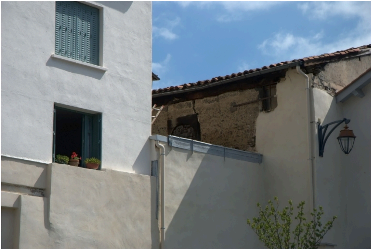
Îlot 4. Clermont (rue de). Détail du pisé en partie haute de la parcelle 597.
