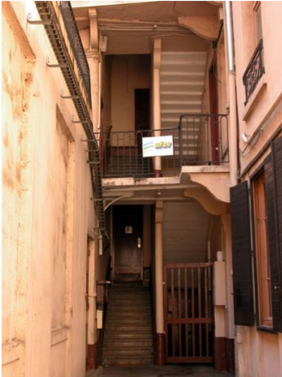
Bâtiment 3 vu depuis la cour III, élévation des 2 premiers niveaux de la cage d'escalier
