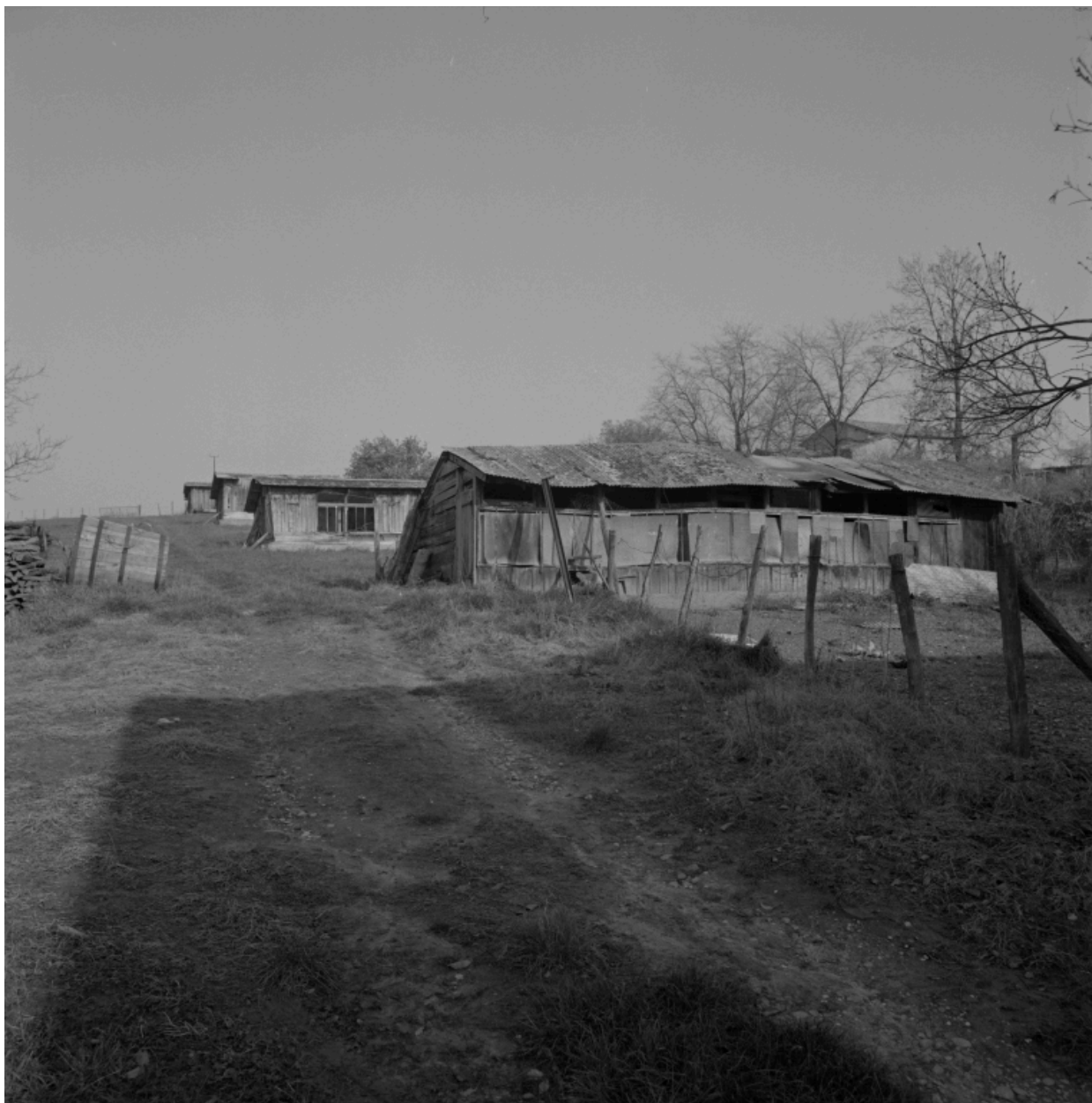
Vue générale des poulaillers en bois, construits derrière la ferme.
