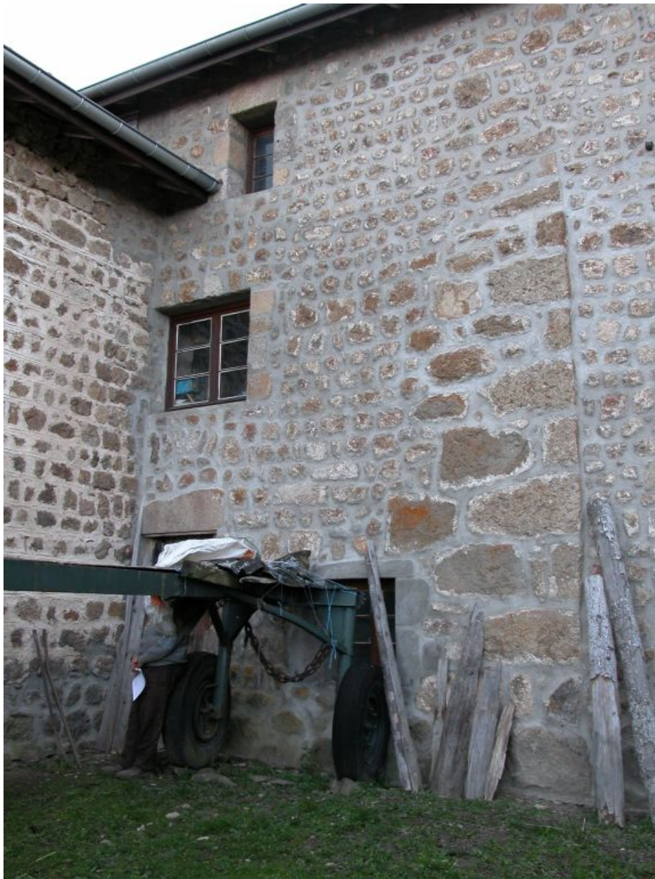
Elévation partielle de l'ancien logis de la ferme (1986 H 120).
