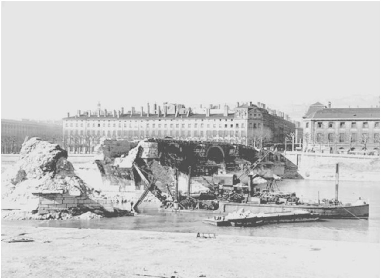
Démolition du pont de la Guillotière. Photogr., 1952 (Musée Gadagne. (9)53.1199.14)
