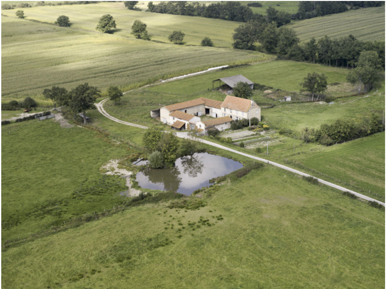
Vue générale aérienne depuis l'est.
